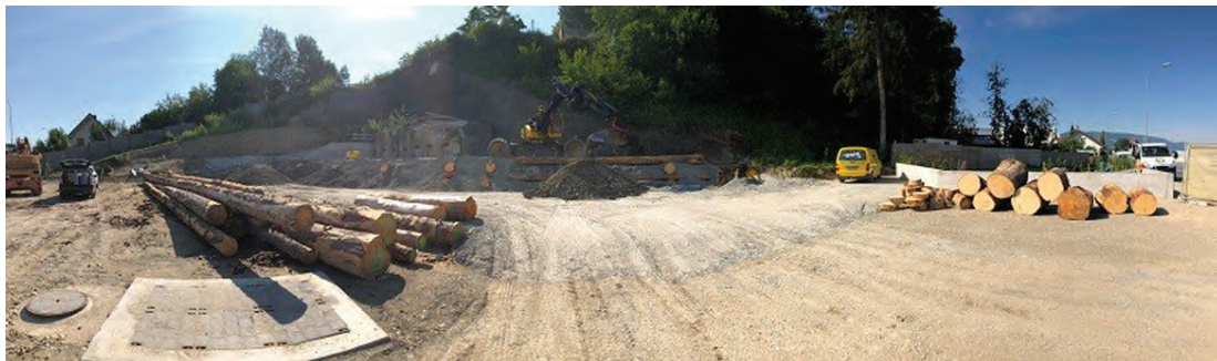
Einbau des Holzkastens auf dem Tunnel-Westportal mitte Juni 2019.
