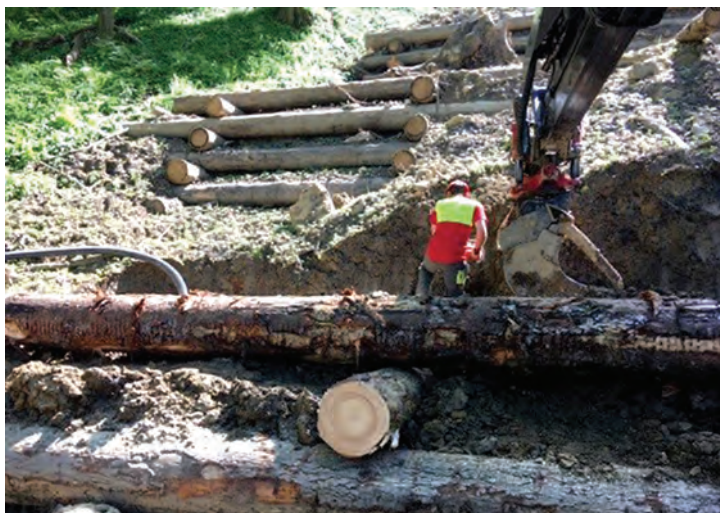
Bauarbeiten beim Holzkasten in Kienberg auf der Saalhöhe Mai 2017.
