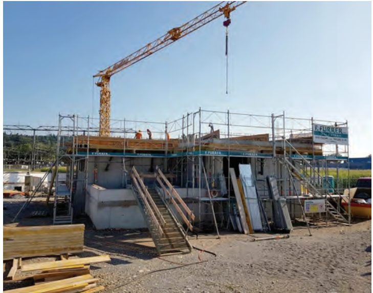
Pumpwerk im Bau.
