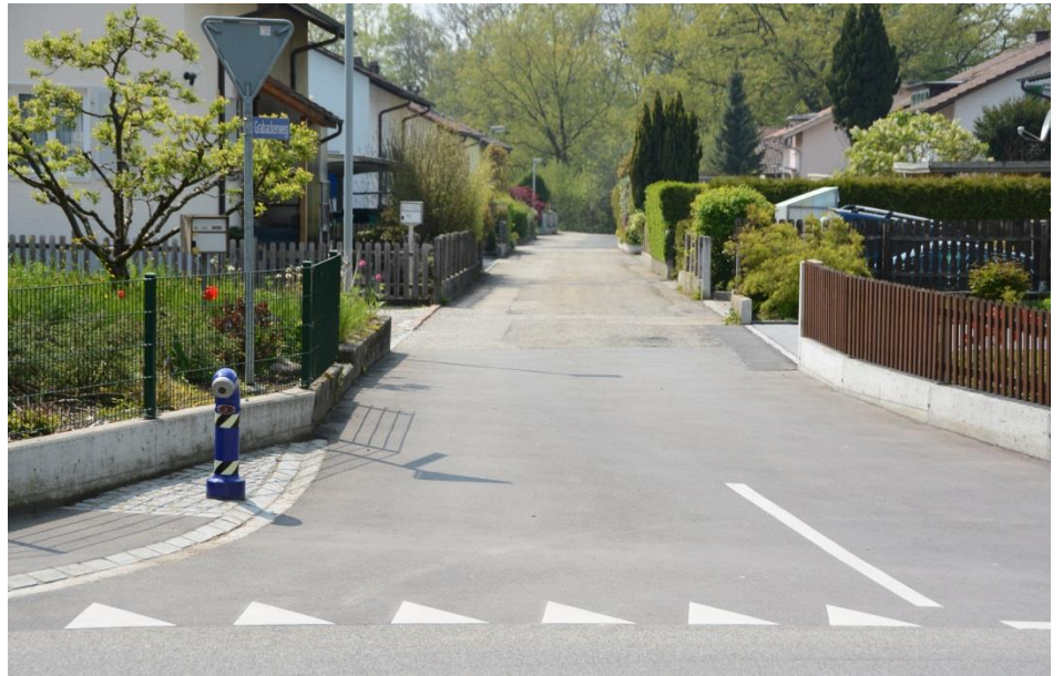
Die Sanierung des Grabackerweges steht an.
