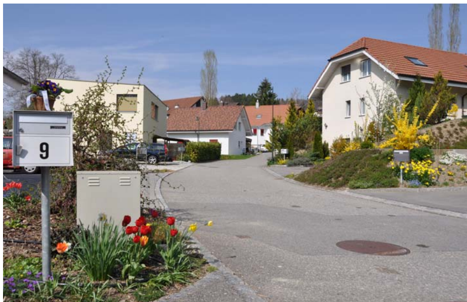
Mühleweg: Bald wird der Deckbelag eingebaut.
