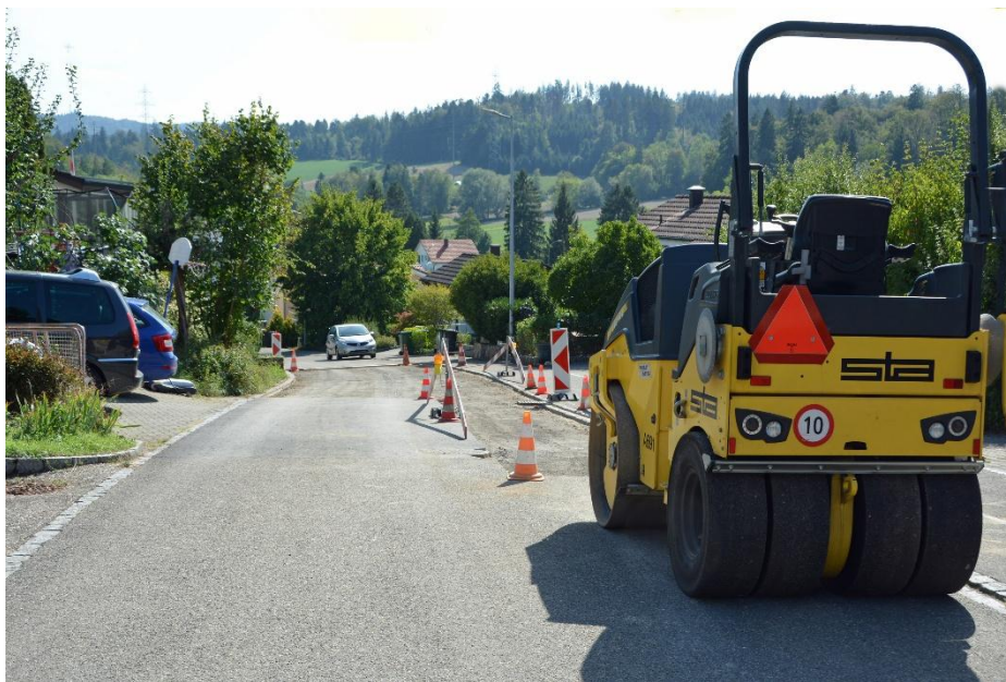
Sanierung der Wasserleitung Rüttenenstrasse
