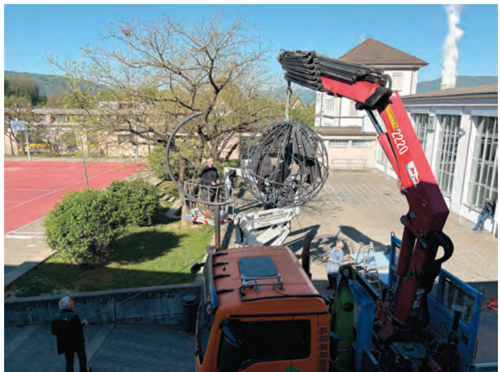
Präzisionsarbeit beim Einbau der Meridiankugel
