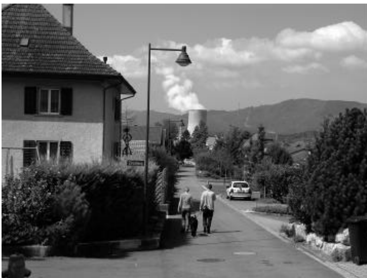
Sängetelstrasse: Die Kanalisationsleitung wird saniert
