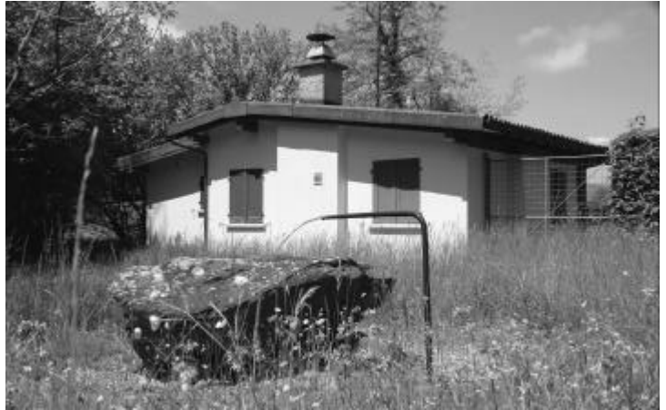
Sanierungsbedürftig: Das idyllisch gelegene Kleinkaliber-Schützenhaus «im Zingg»
