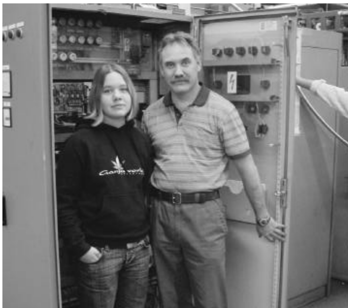
Vater und Tochter überprüfen einen Steuerungsschrank
