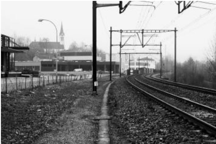
Bahngleis erhält Kanalisationsanschluss
