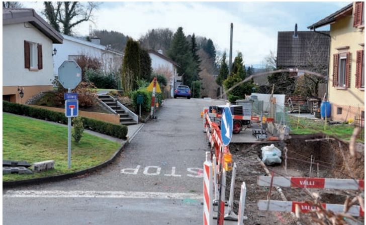
Im Frühjahr soll der Täliweg saniert werden.
