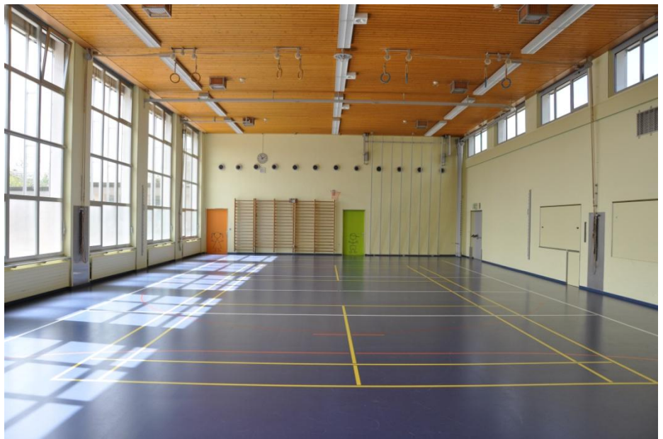
Das Endprodukt der Sanierung Turnhalle 57
