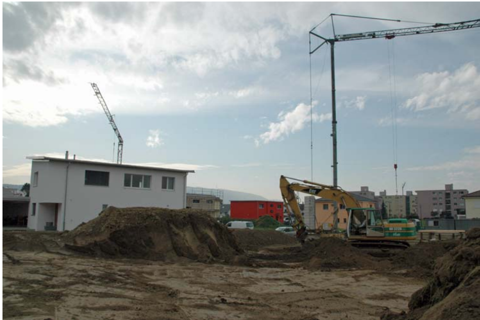
Teilrevision der Gemeindeordnung / Neue Aufgabenteilung bei der Baulanderschliessung:
