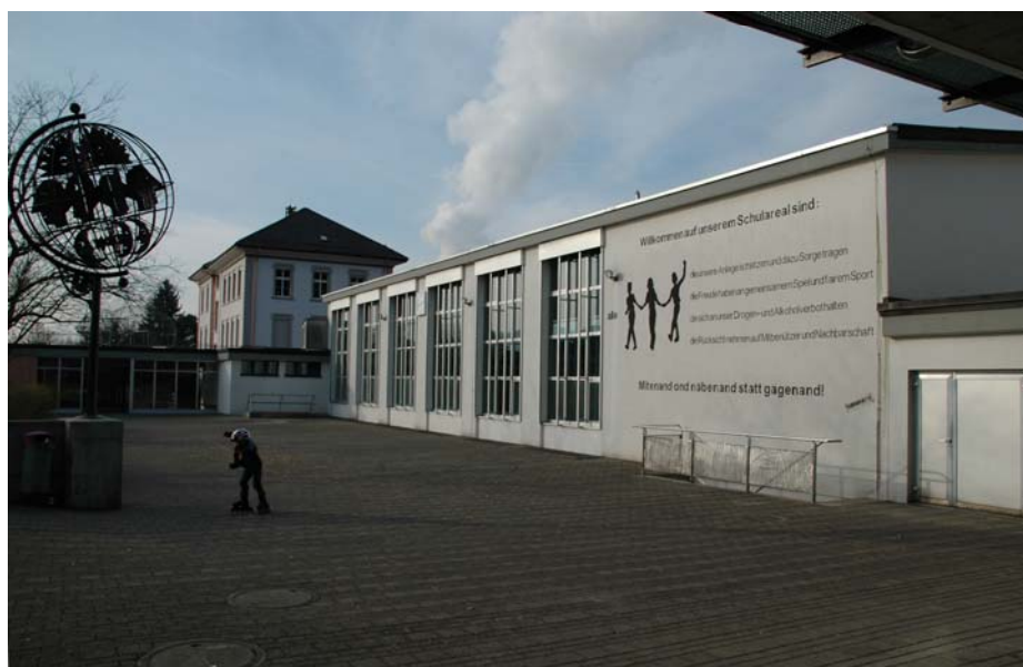
Im Rahmen der Investitionen 2009 wird auch die Turnhalle 57 saniert. FOTO: HANS BEER
