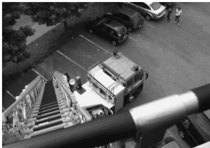
Die moderne Drehleiter bringt die Zweiergondel innert Kürze über das Dach des alten Schulhauses hinauf.
