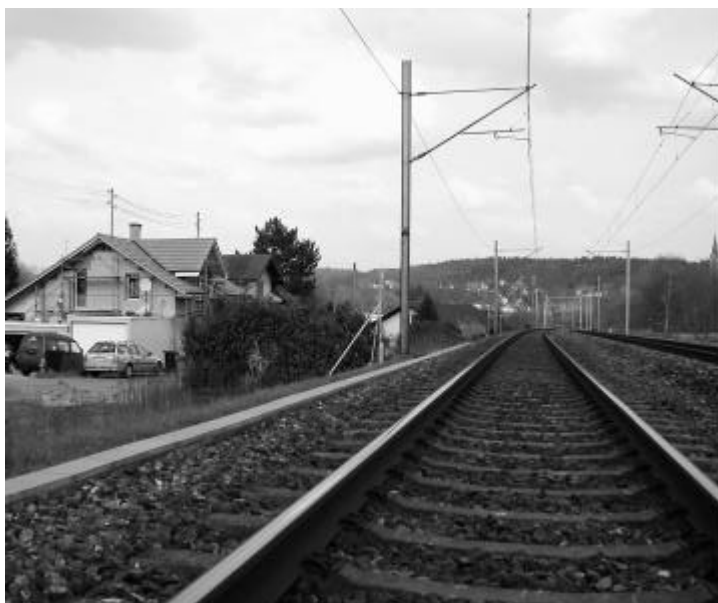
Lärmschutzwand «Unterer Schachen».
