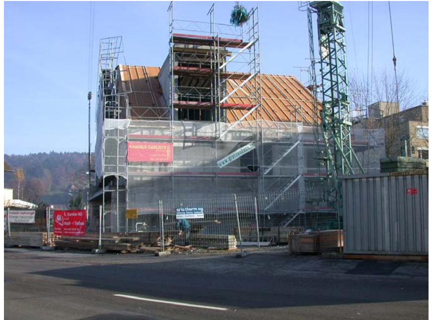
Termingerecht unter Dach: Das neue Gretzenbacher Gemeindehaus
