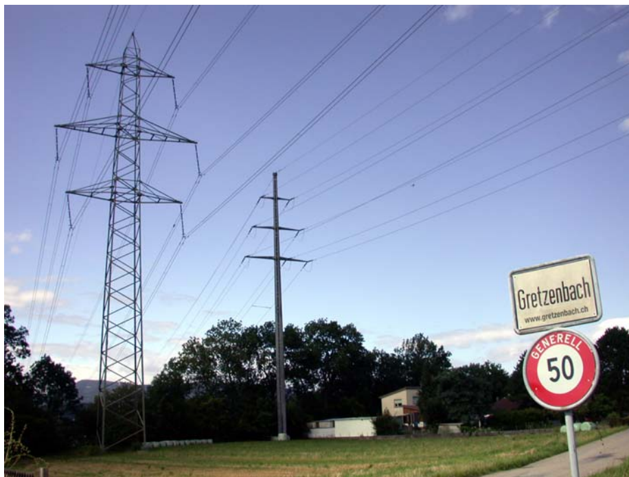
Wer soll Gretzenbach künftig mit Strom versorgen?
