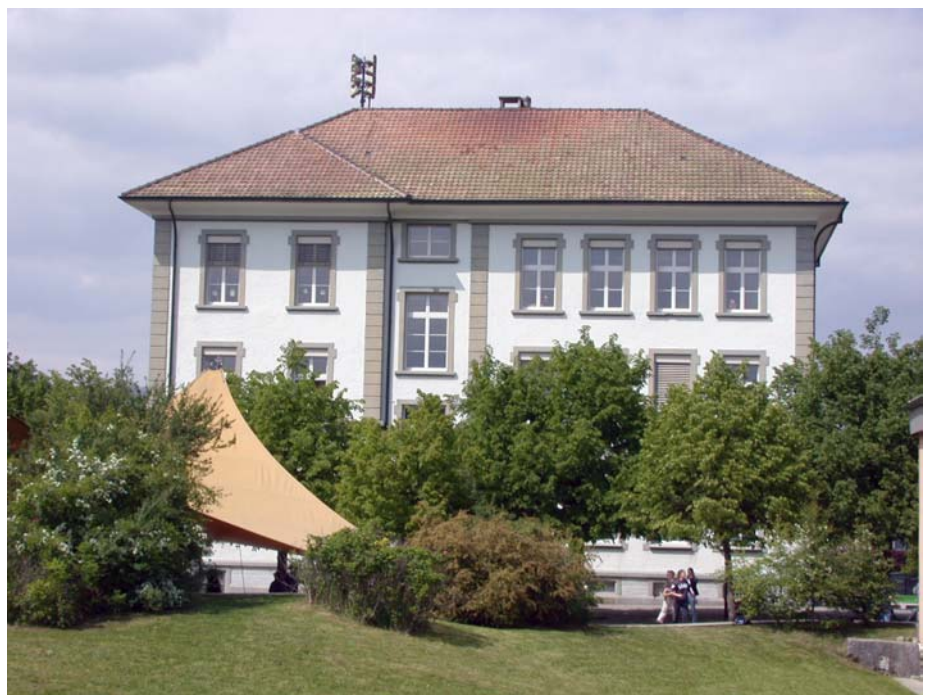
Neue Fenster für altes Schulhaus 1896.
