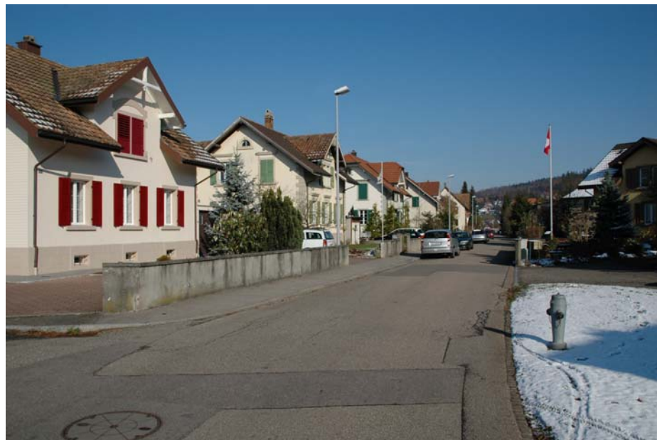
Kanalisationssanierungen Kirchenfeldstrasse (Bild) und Frybackerstrasse sollen rund 210'000 Franken kosten.
