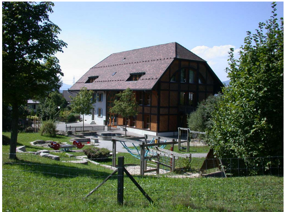
Das Kindergartenhaus erhält teilweise neue Fenster
