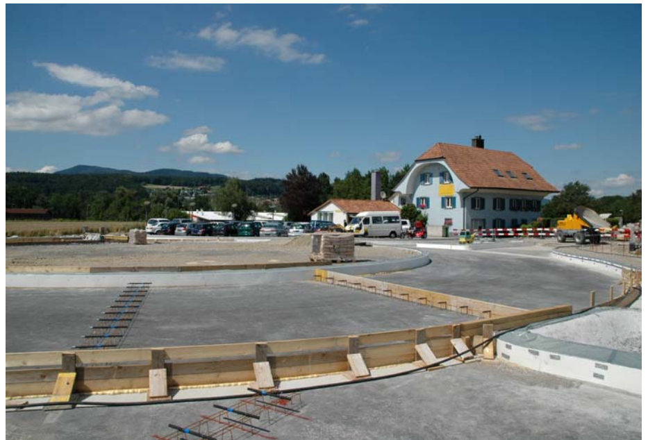
Baustelle Kreisel Oltnerstrasse T5.
