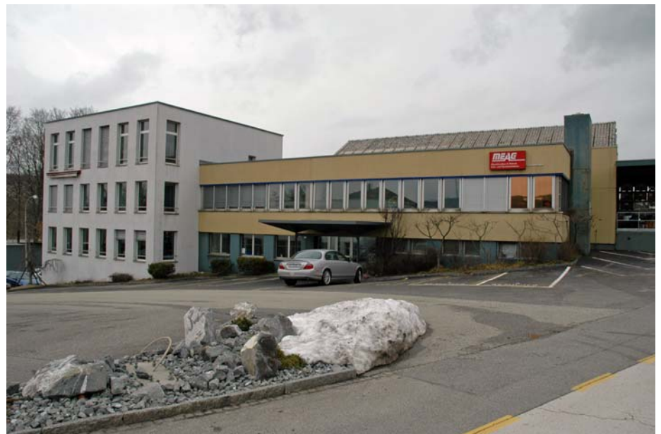
Die Betriebserweiterung der Meag an der Oltnerstrasse in Gretzenbach macht eine neue Trafostation nötig.
