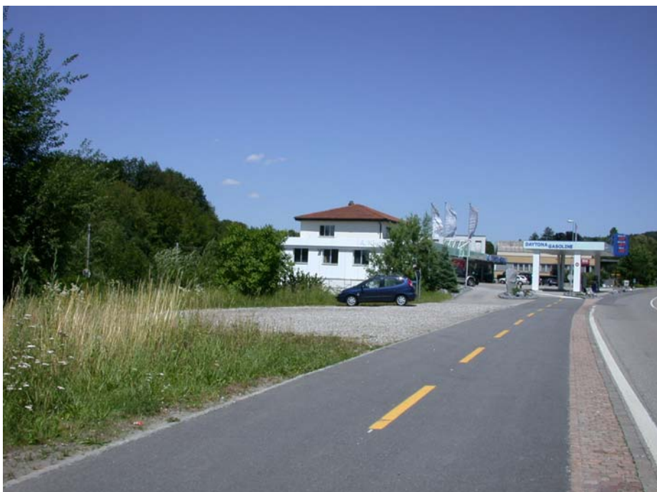
Geplanter Parkplatz für Bally-Park (links im Bild)
